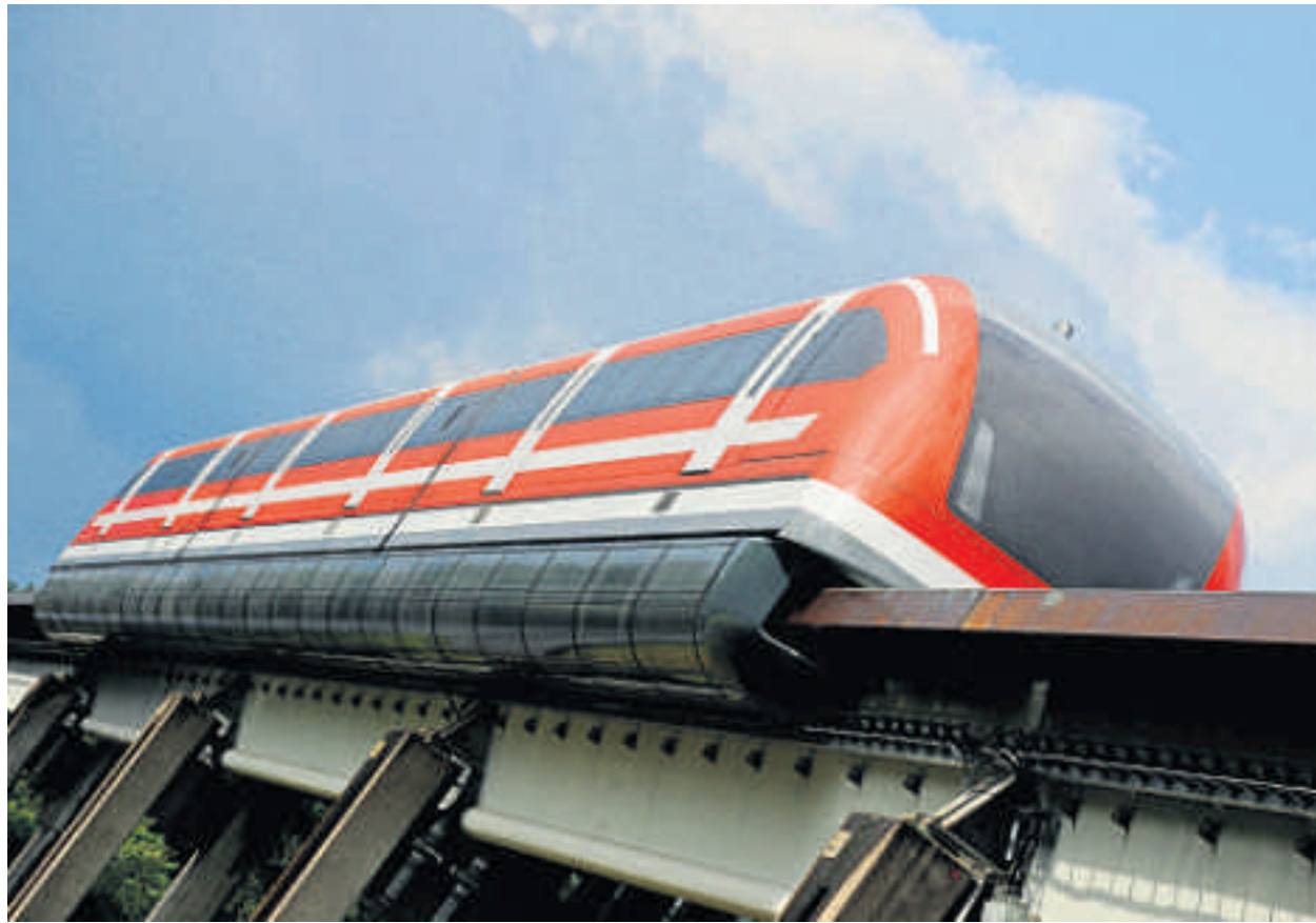
Ein Transrapid TR 09 auf der Magnetschwebebahn-Teststrecke im Emsland.
